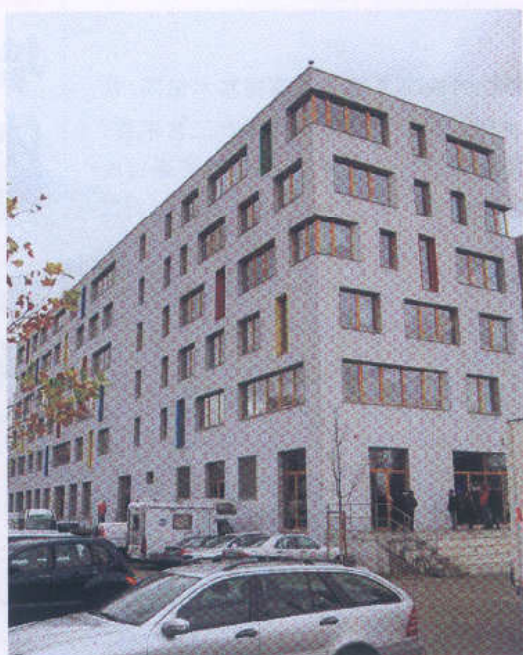
■ 岩棉薄抹灰外墙外保温工程(巴登符腾堡州体育之家 位于斯图加特 Ecke Benzstraße/Martin-Schrenk-Weg, Stuttgart, 建于2002年, 满足被动节能建筑能耗要求)
